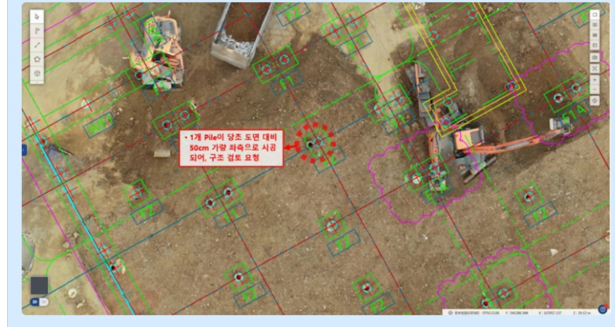
드론을 활용한 기초 파일 시공 위치 검증
